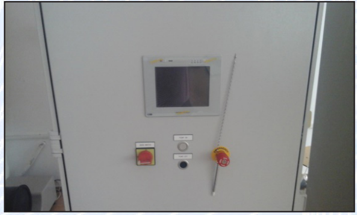
Fig. 62. b. Panou PLC
