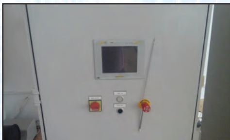
Fig. 64. Panoul PLC de la instalatia de plasma
