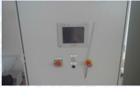
Fig. 70. Panoul PLC de la instalatia de plasma
